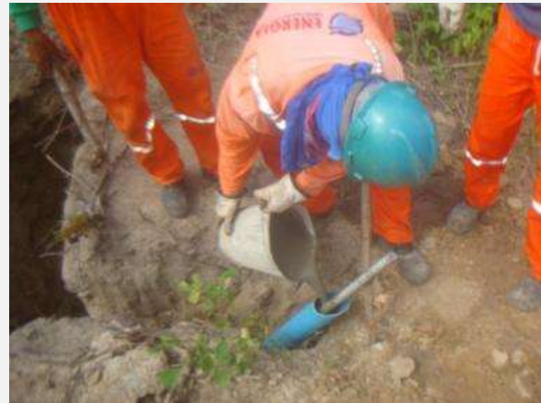
Reaterramento da cava após a instalação do tirante
