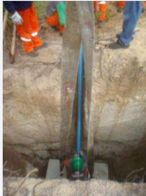
Aplicação da haste com espaçadores e tubos
